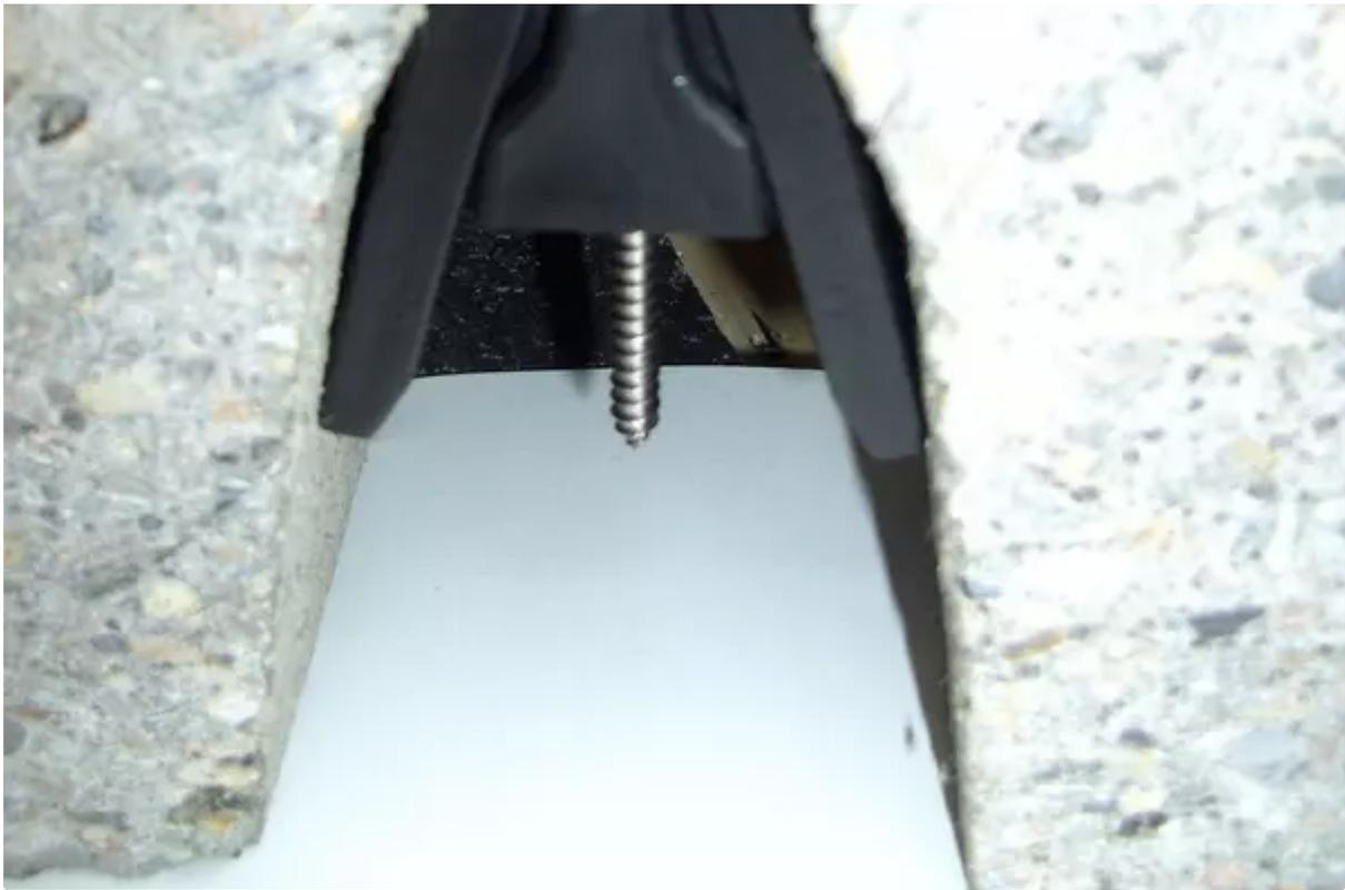
So verkeilt sich das Slat Lock-System in den Betonspalten. (Bildquelle: Stallfit)
