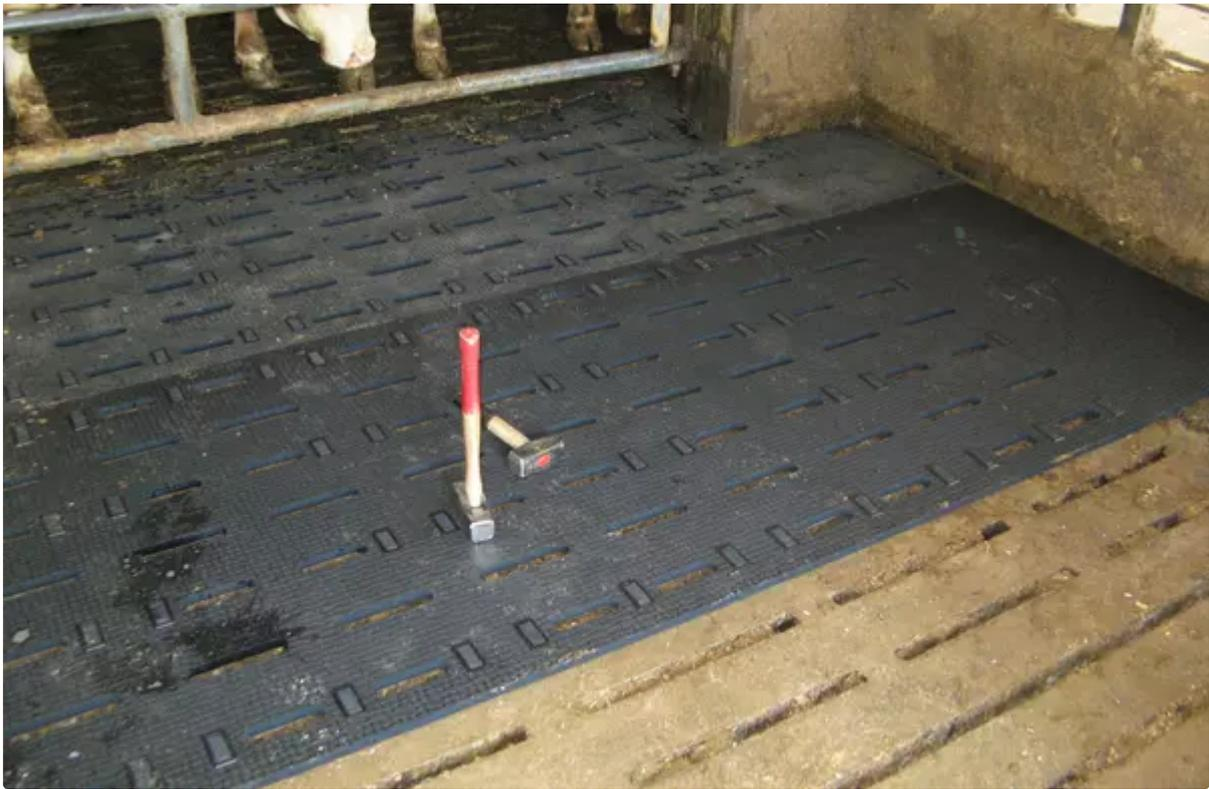
*Bei der Montage der Kraiburg-Matten (hier das Modell Kura S) werden Gummikeile mit dem Hammer eingeschlagen. (Bildquelle: Kraiburg)*
